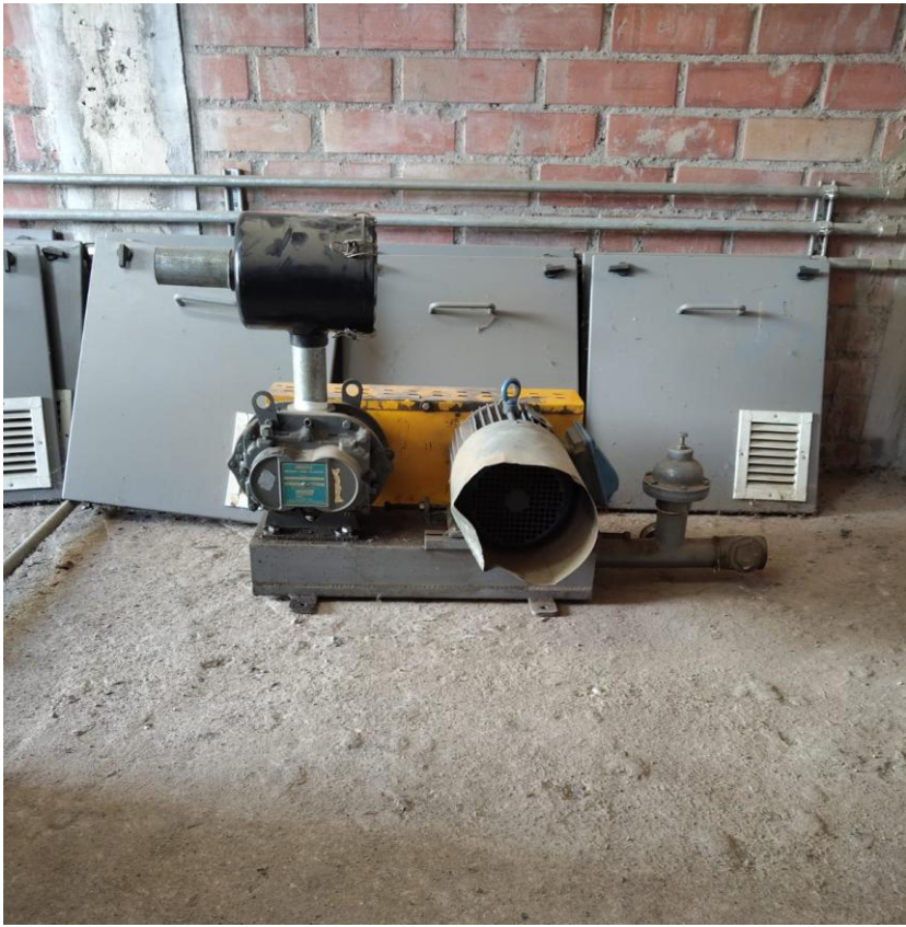
Soplador defectuoso
